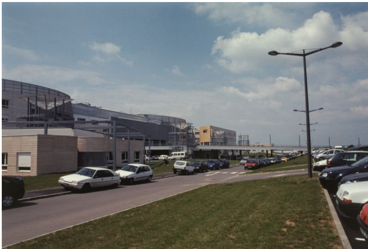
Façade antérieure, vue d'ensemble.
