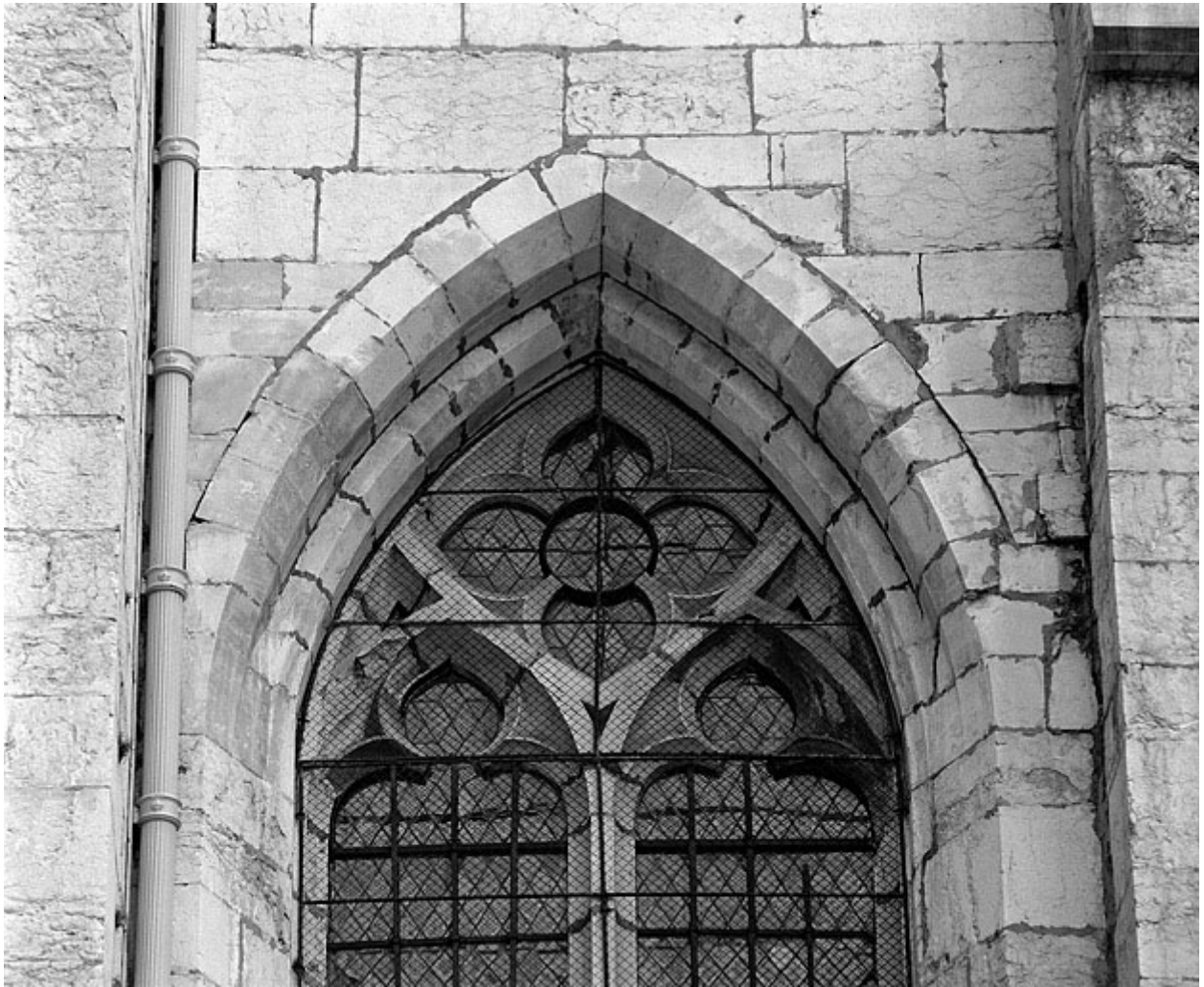
Détail de la baie orientale de l'ancienne chapelle de Neuville.
