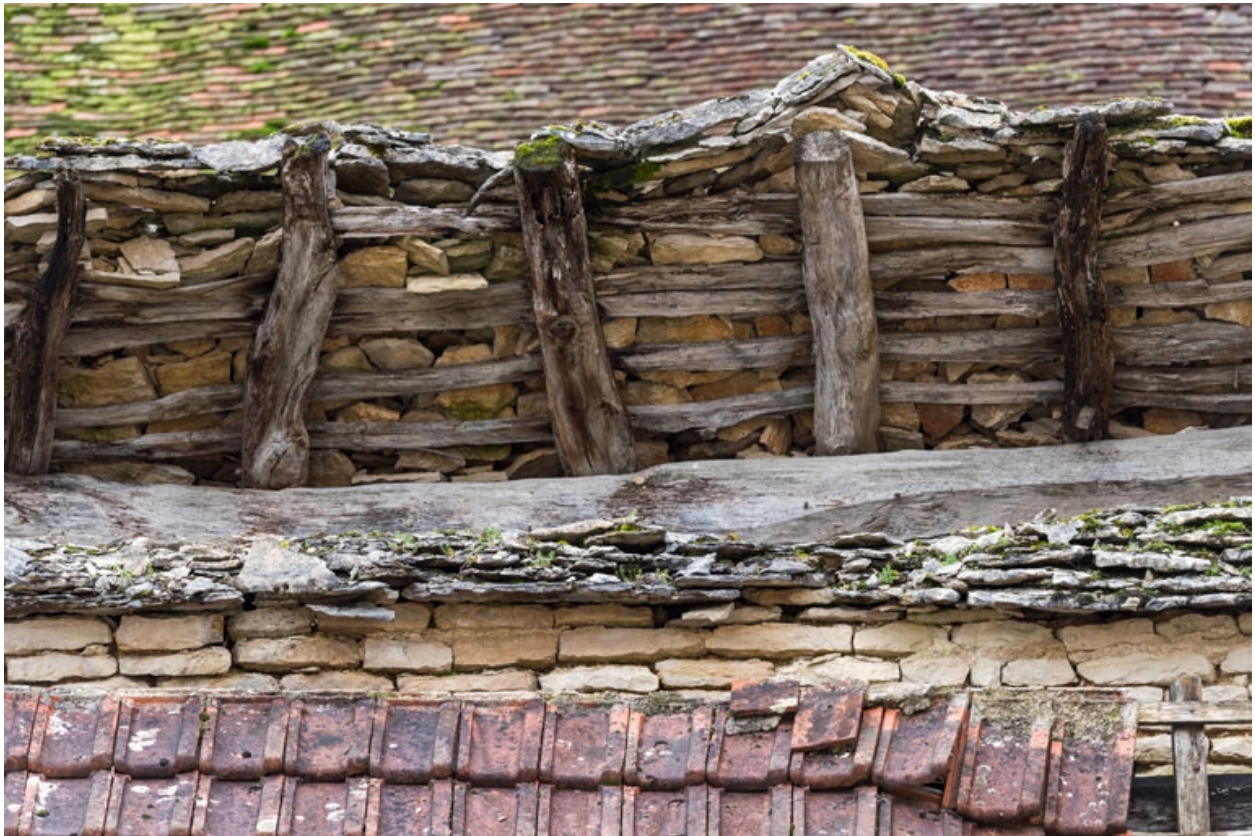
Détail de la toiture côté est.
