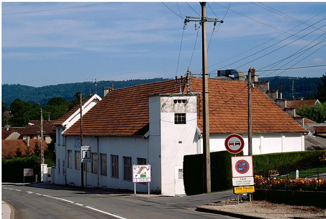
Atelier de fabrication rue Progin.
