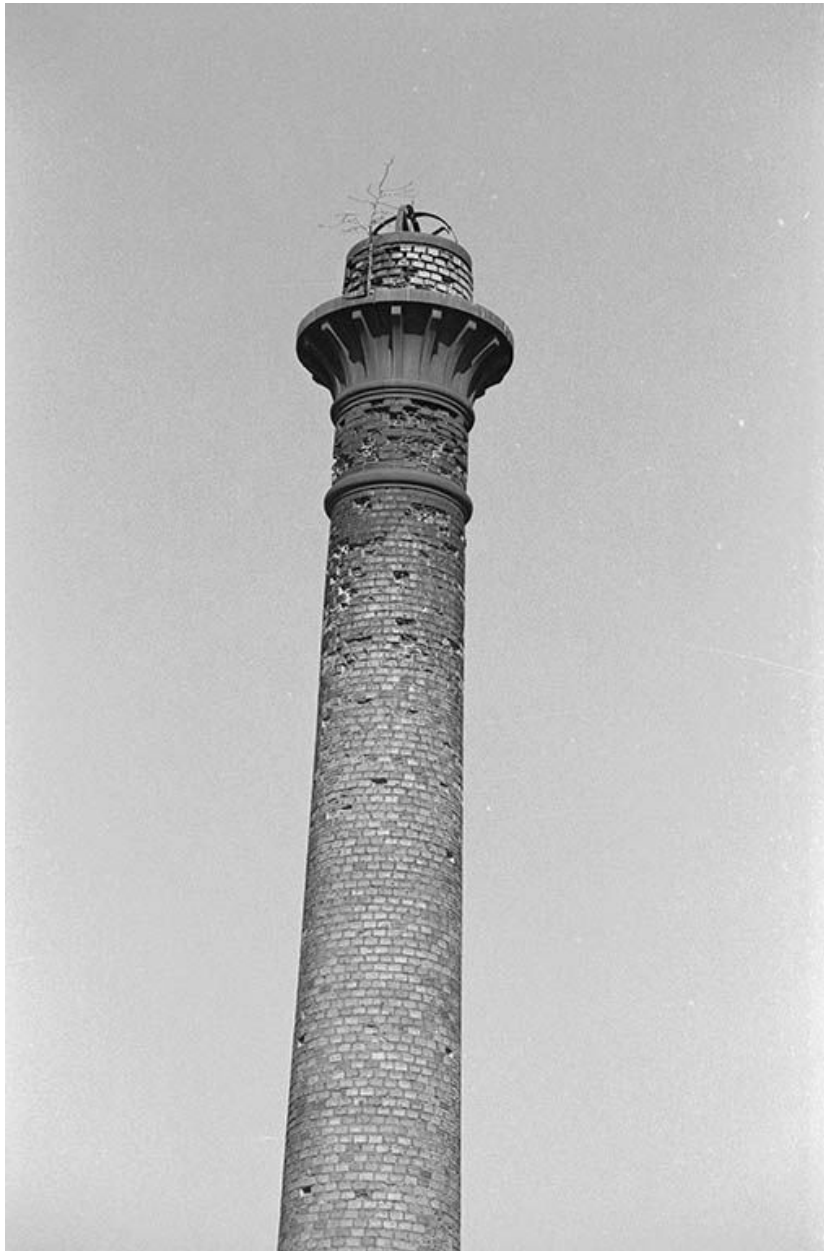
Cheminée des ateliers et son couronnement en fonte.
