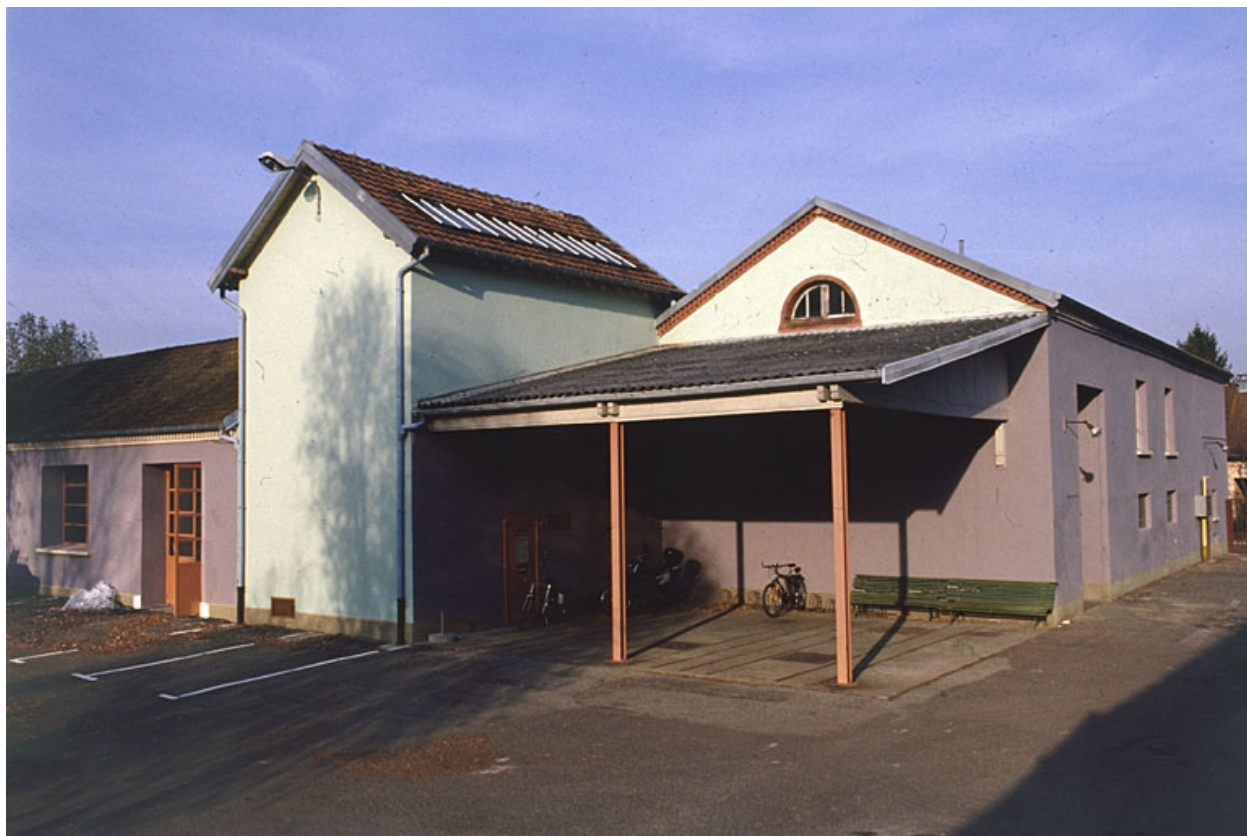
Chaufferie et atelier de forge.
