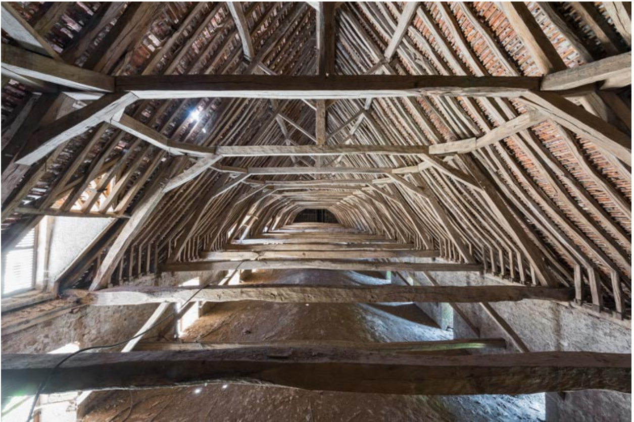
Ecurie, étage de comble : charpente.
