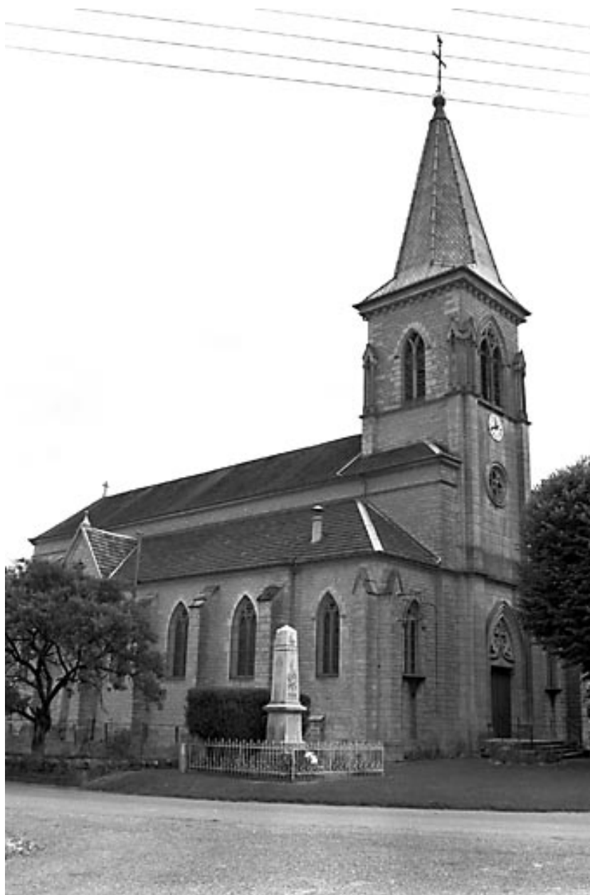
Façades antérieure et latérale gauche.
