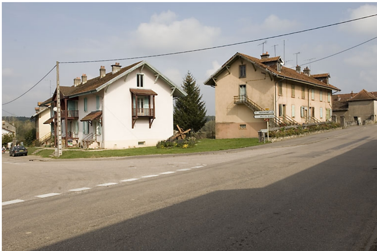
Logements ouvriers à l'angle de la grande rue et de la route de Passavant.
