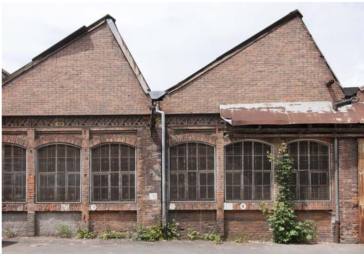
Atelier de fabrication. Pignons de sheds.
