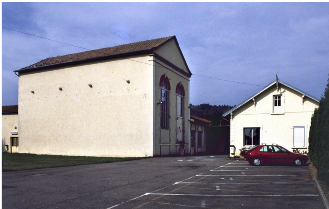
La salle des machines.
