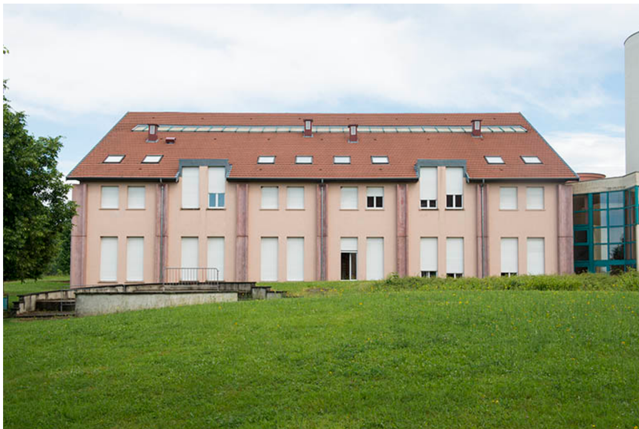
Façade antérieure sud de l'internat sud-ouest.
