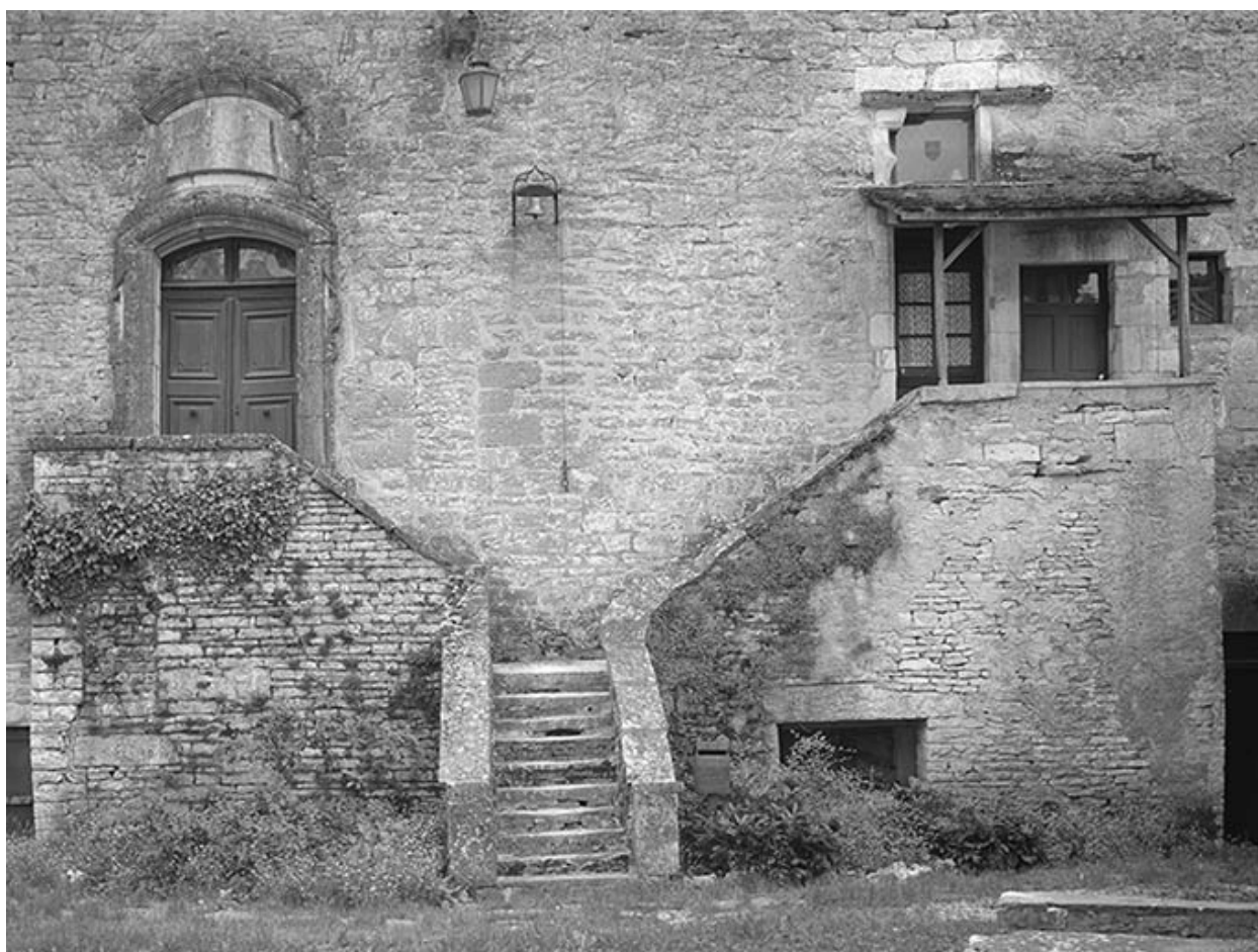
Façade antérieure : escalier desservant l'étage d'habitation.
