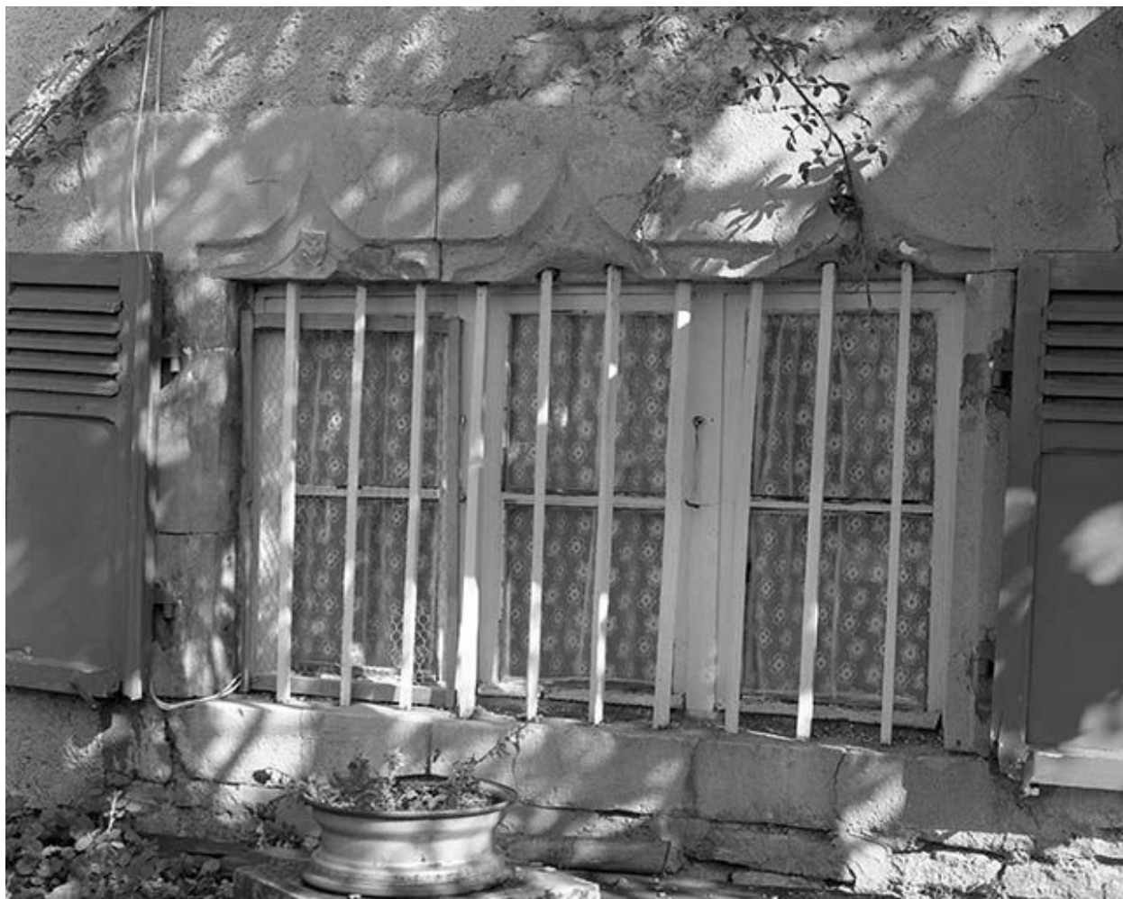
Façade postérieure : baie du rez-de-chaussée.
