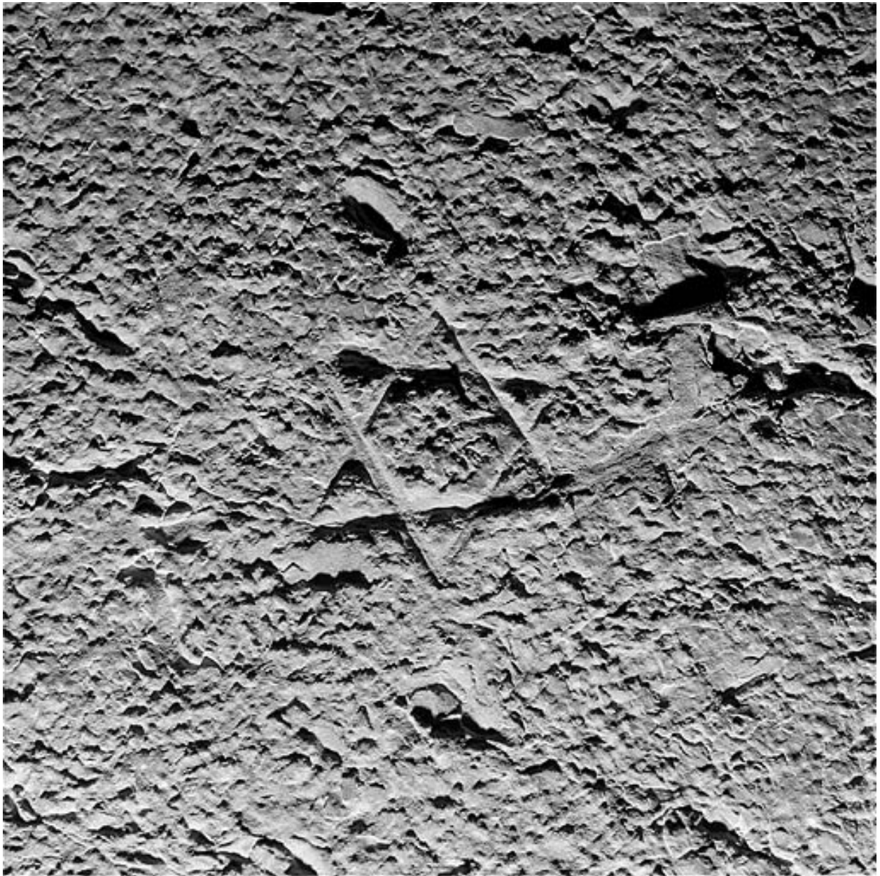
Traces de boucharde et signe lapidaire sur le revers de la façade au nord.
