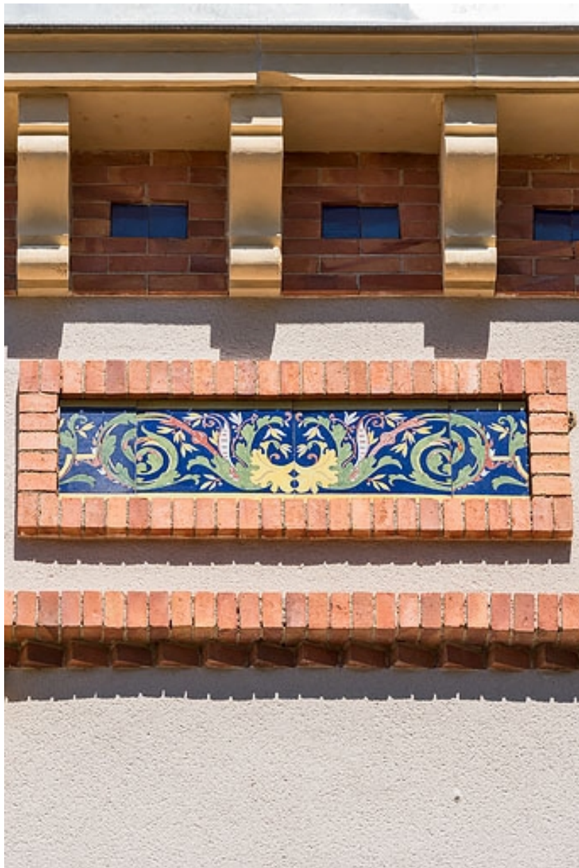
Avant-corps central de la façade principale, détail.
