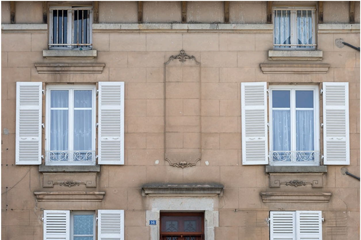
Détail de la façade sur rue.
