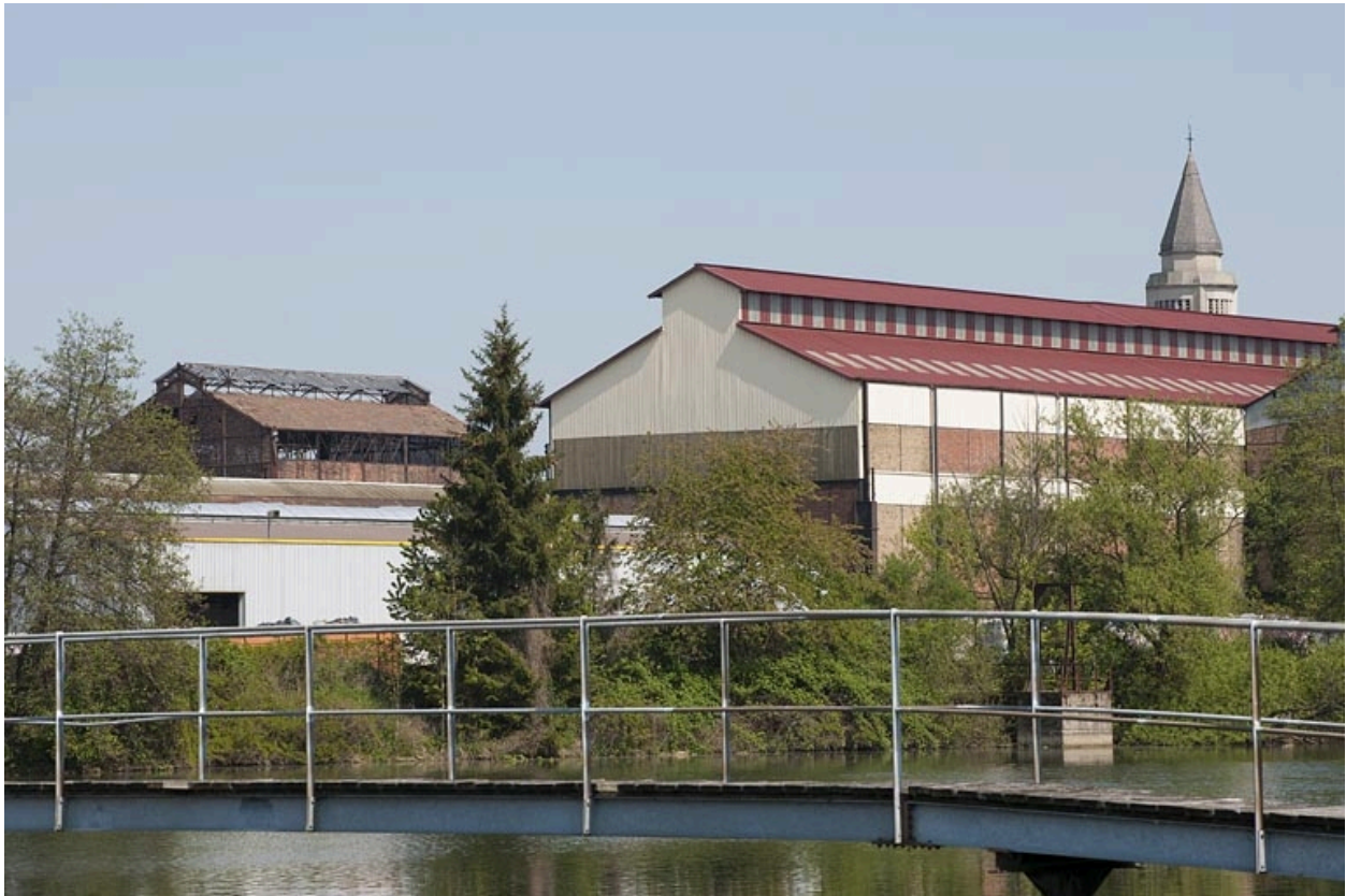
Les bâtiments du gazogène et de l'aciérie depuis le barrage.
