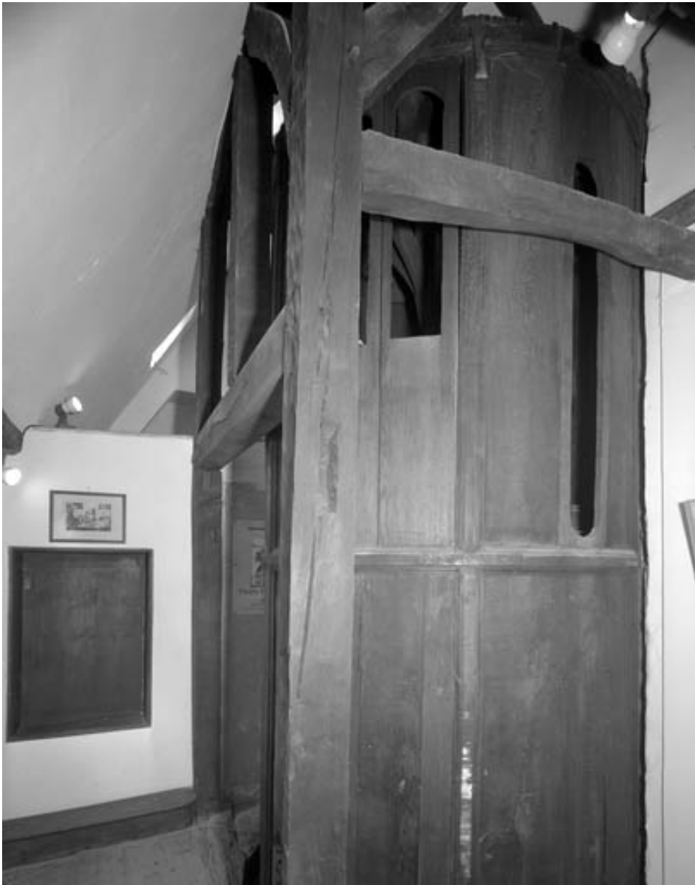
Détail du cylindre pivotant fermé, vu au niveau de la cellule de saint Pierre Fourier.
