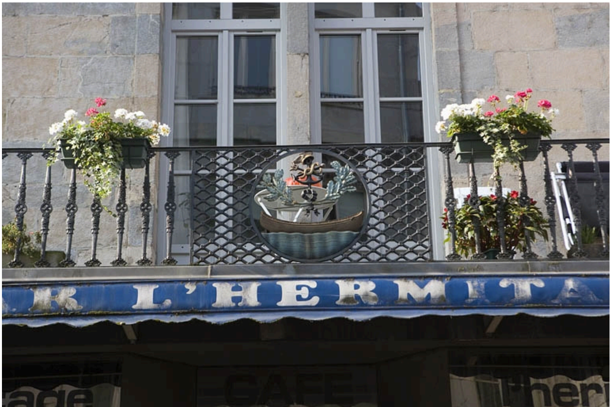
Détail du balcon sur la partie centrale de la façade sur rue, de face.
