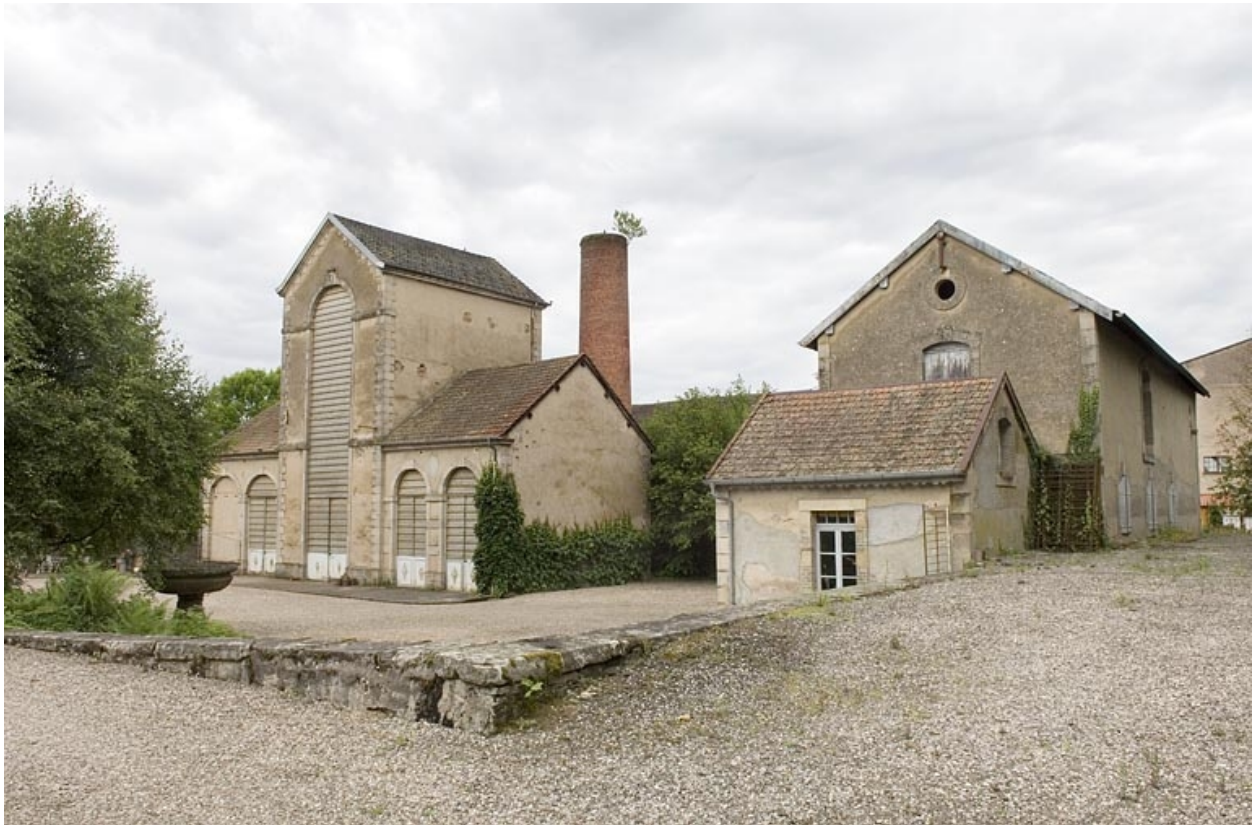
Bâtiment de rectification, bureau et entrepôt industriel.
