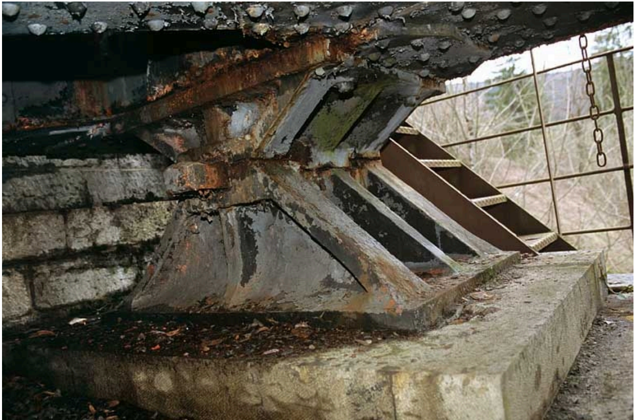
Appui fixe (extrémité côté La Cluse, à l'aval).
