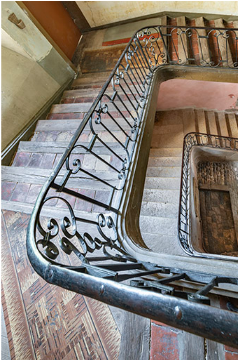
Vue plongeante sur la cage d'escalier.
