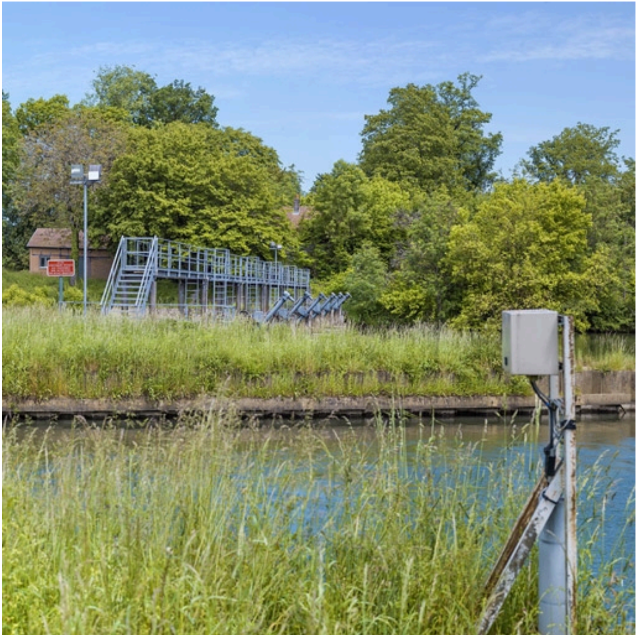
Les vérens du barrage.
