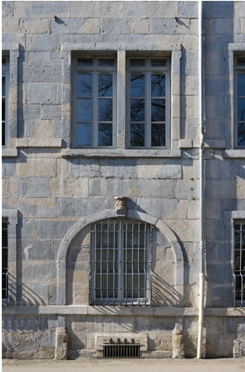
Détail de quelques baies sur la façade latérale gauche.
