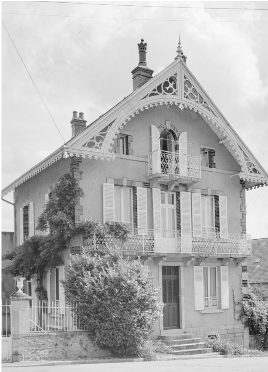
Façade principale sur l'avenue Eugène Collin, vue en 1978.
