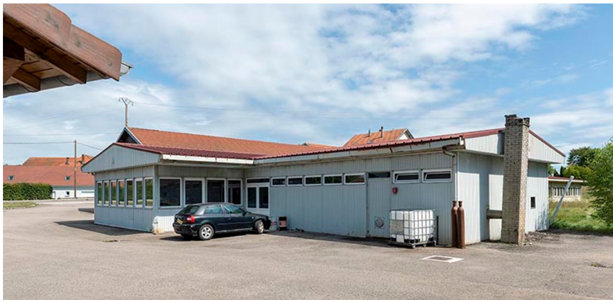
Façade latérale droite, de trois quarts droite.
