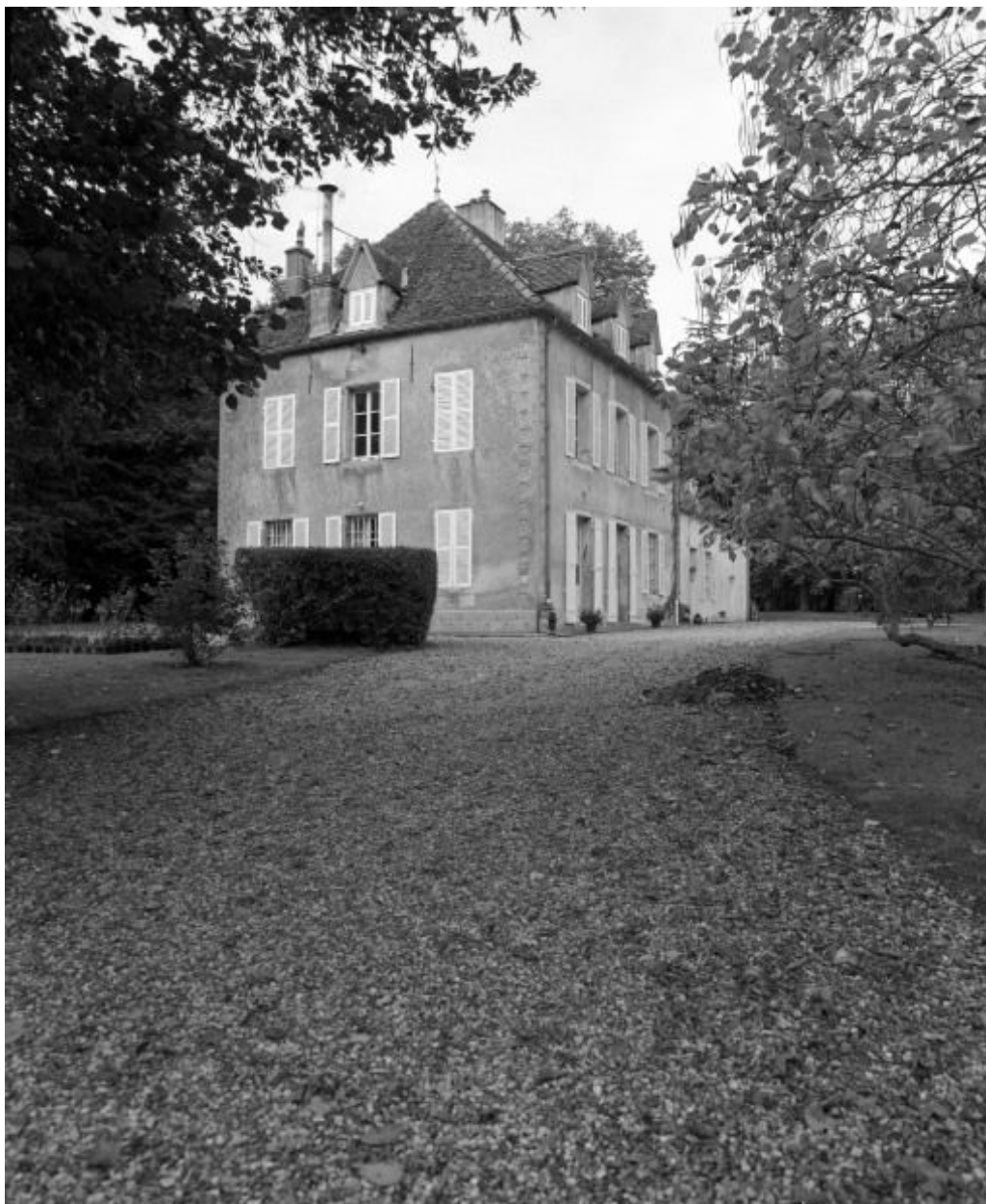
Logis, élévation gauche.
