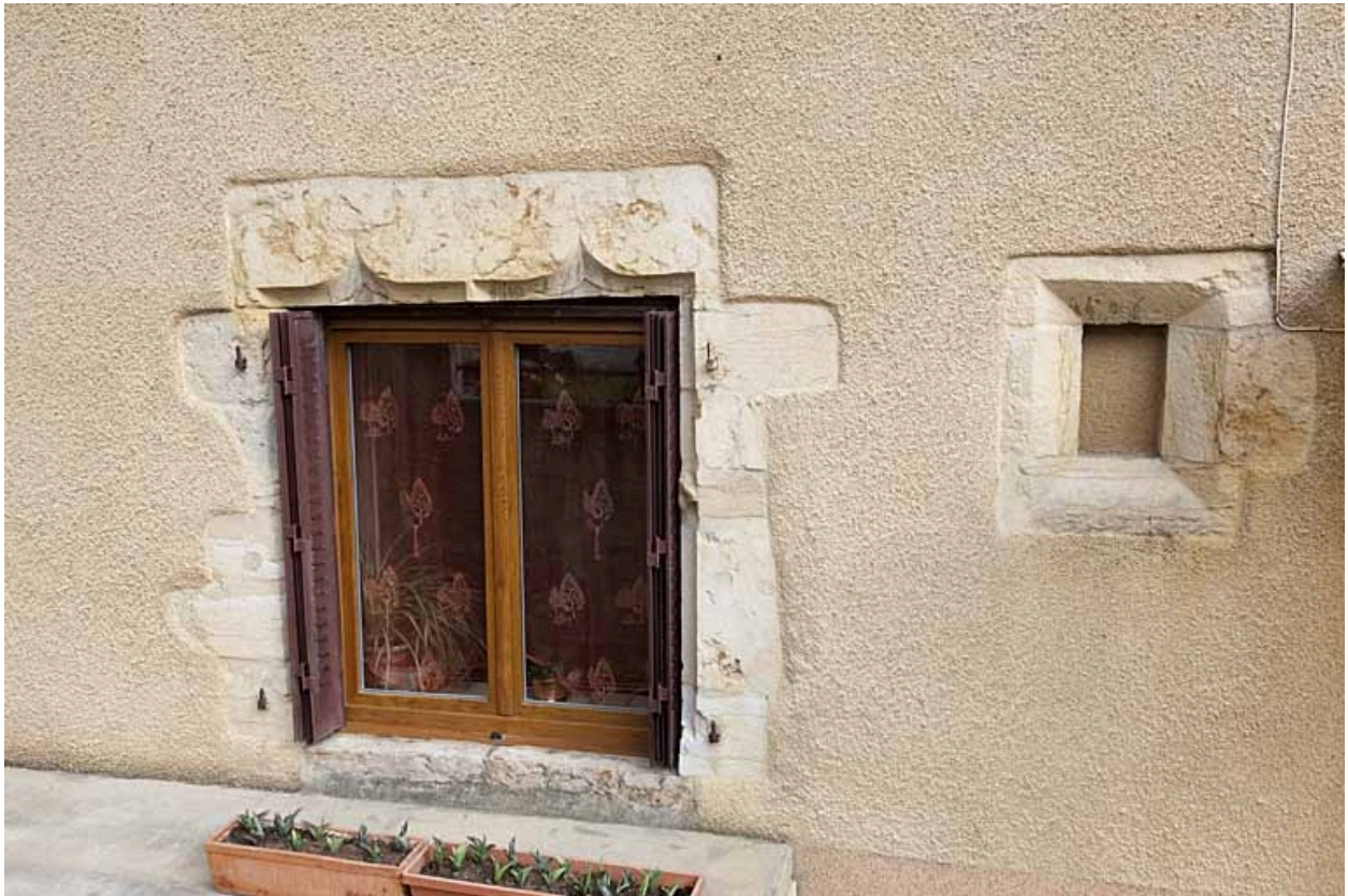
Fenêtre à linteau en arc en accolade de la maison au 12 Grande Rue (2010 AL 47).
