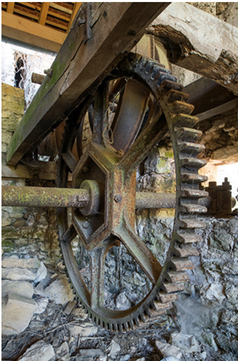
Détail du mécanisme de la minoterie.
