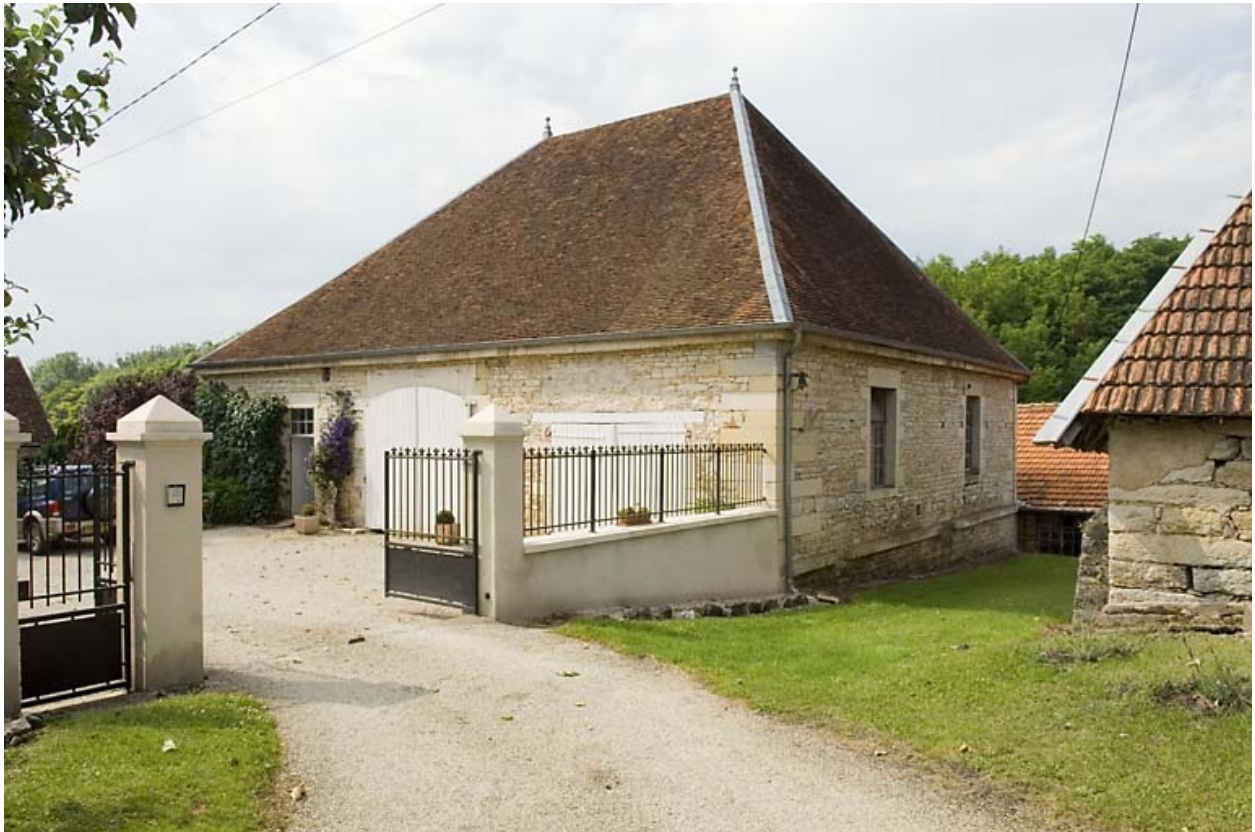
Le haut fourneau vu depuis le sud-est.
