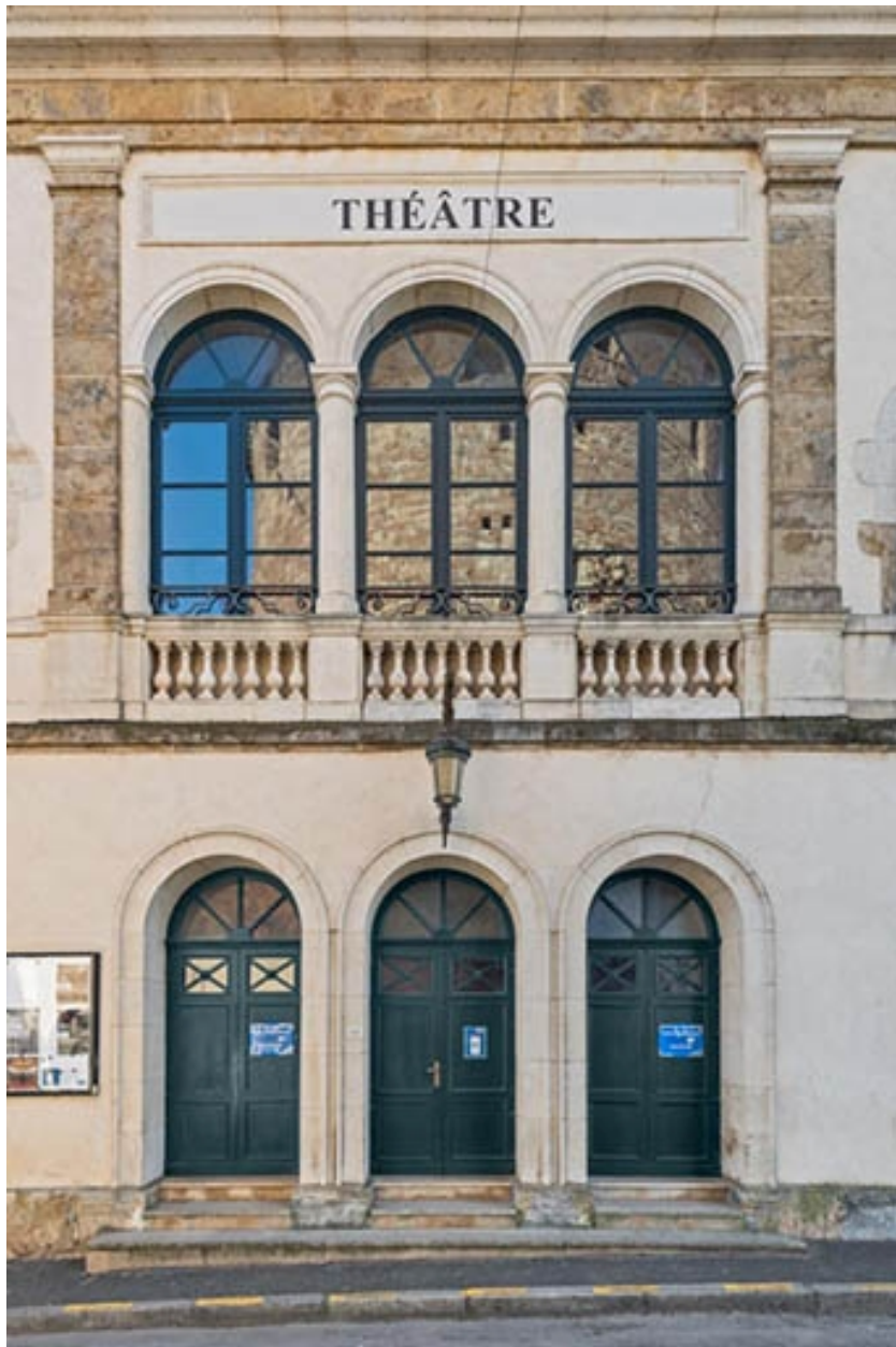
Façade antérieure : travées centrales.
