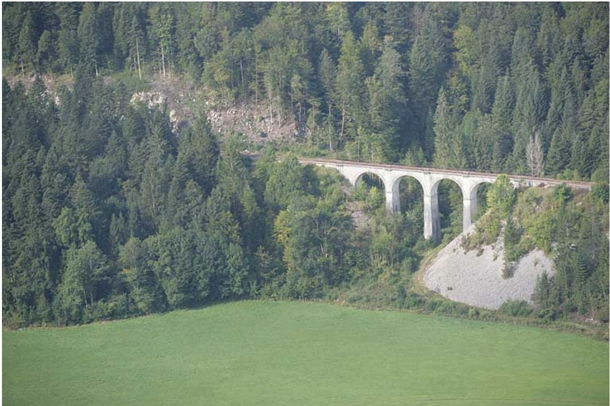
Vue aérienne, depuis le nord-est.
