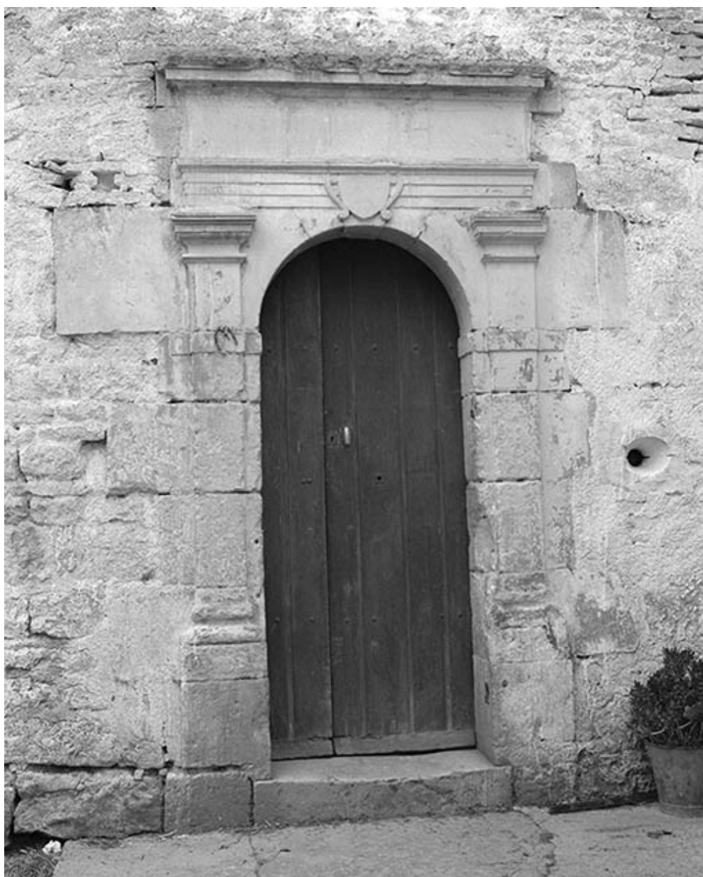
Porte d'entrée de la tour.
