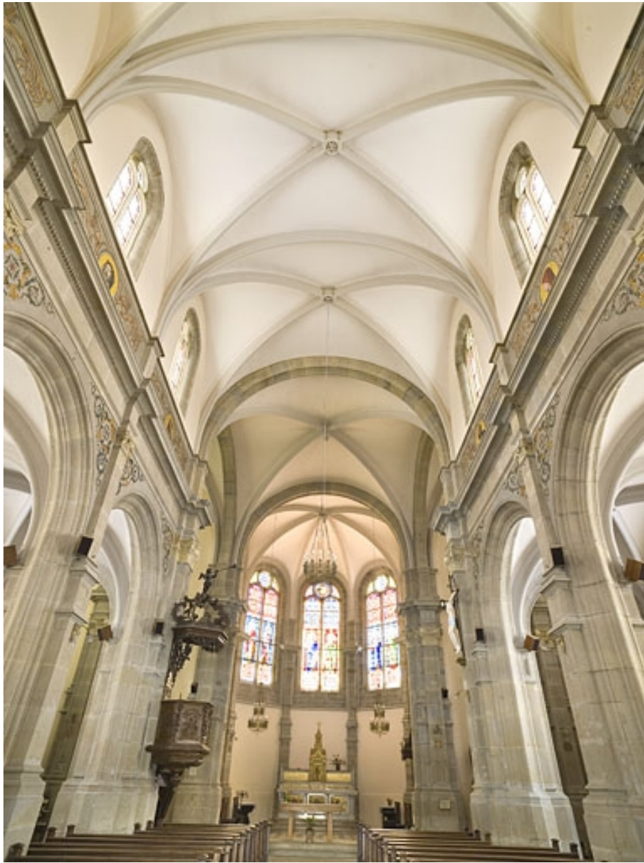
Voûtes de la nef, vues de l'entrée.
