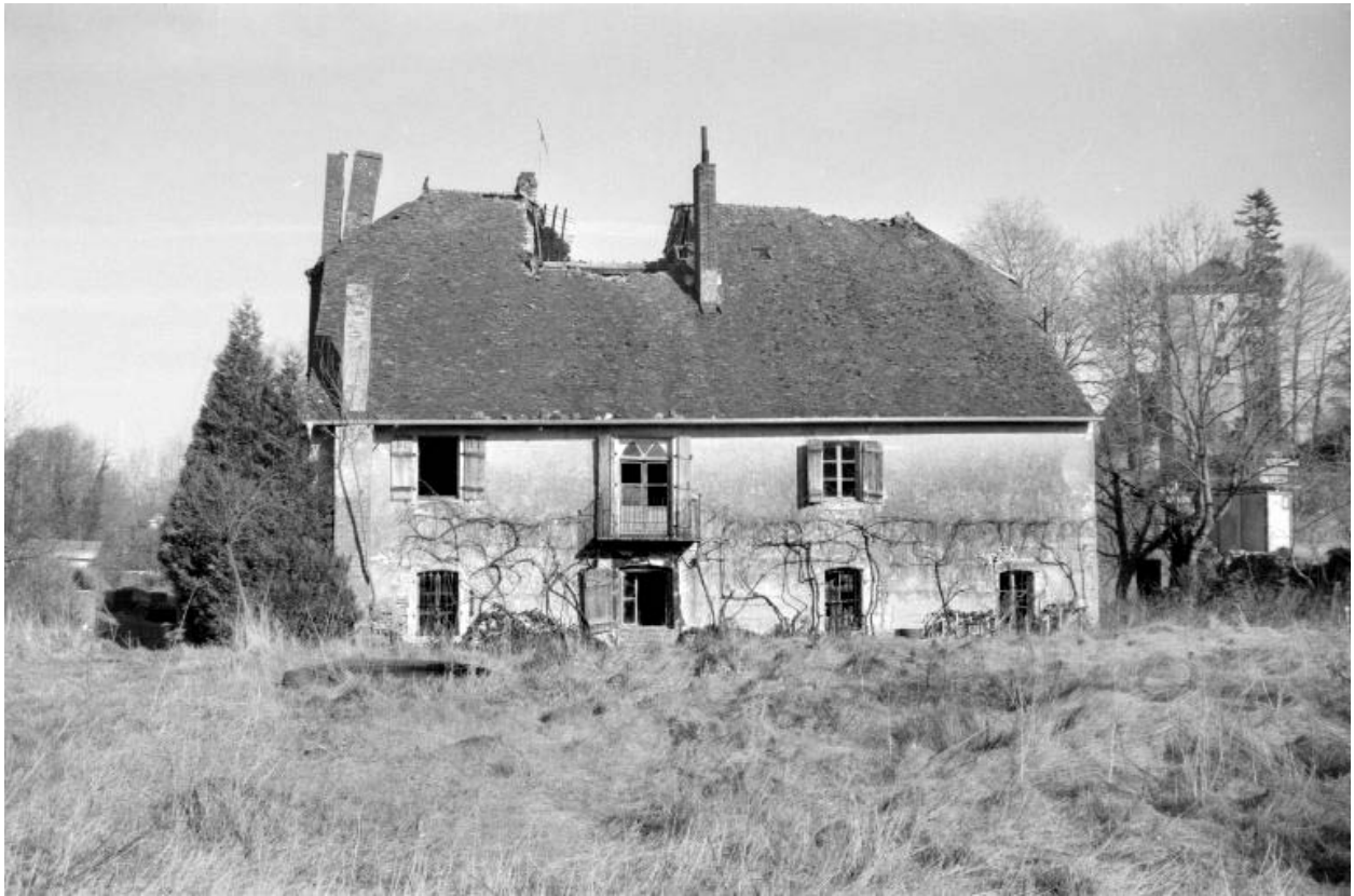
Façade postérieure du logement patronal.
