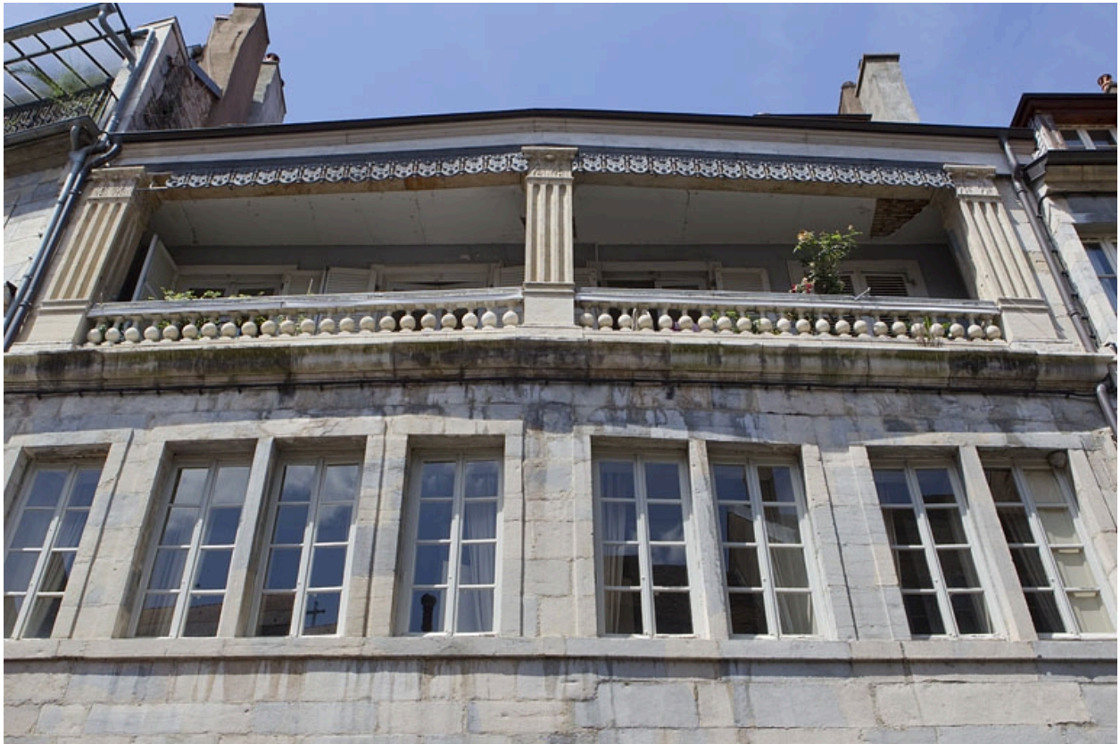
Façade sur rue du logis principal : détail de l'étage de surélévation, de face.
