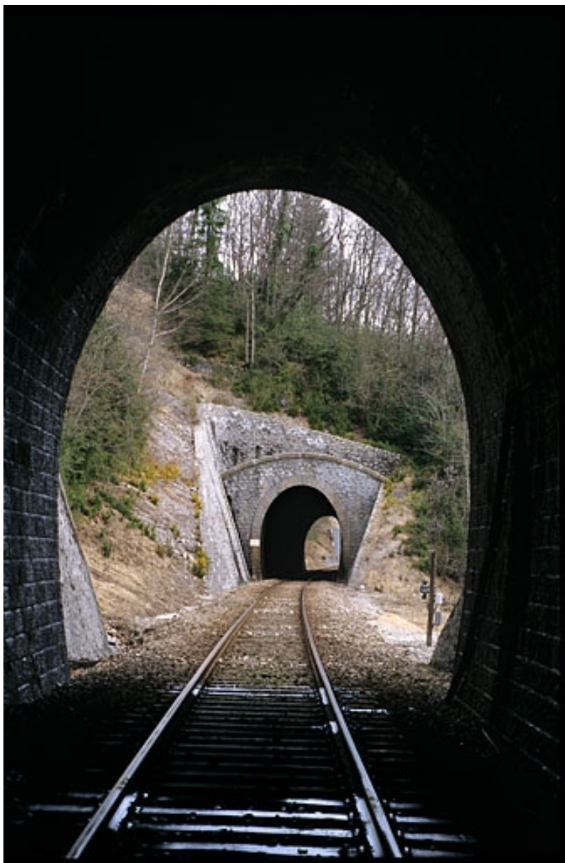
Exemples de tunnels. tunnel de Sous la Côte vu du tunnel des Frettes (La Rixouse).
