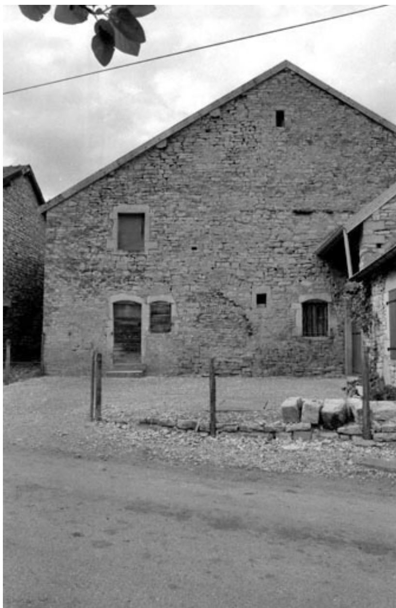
Maison située Grande Rue.
