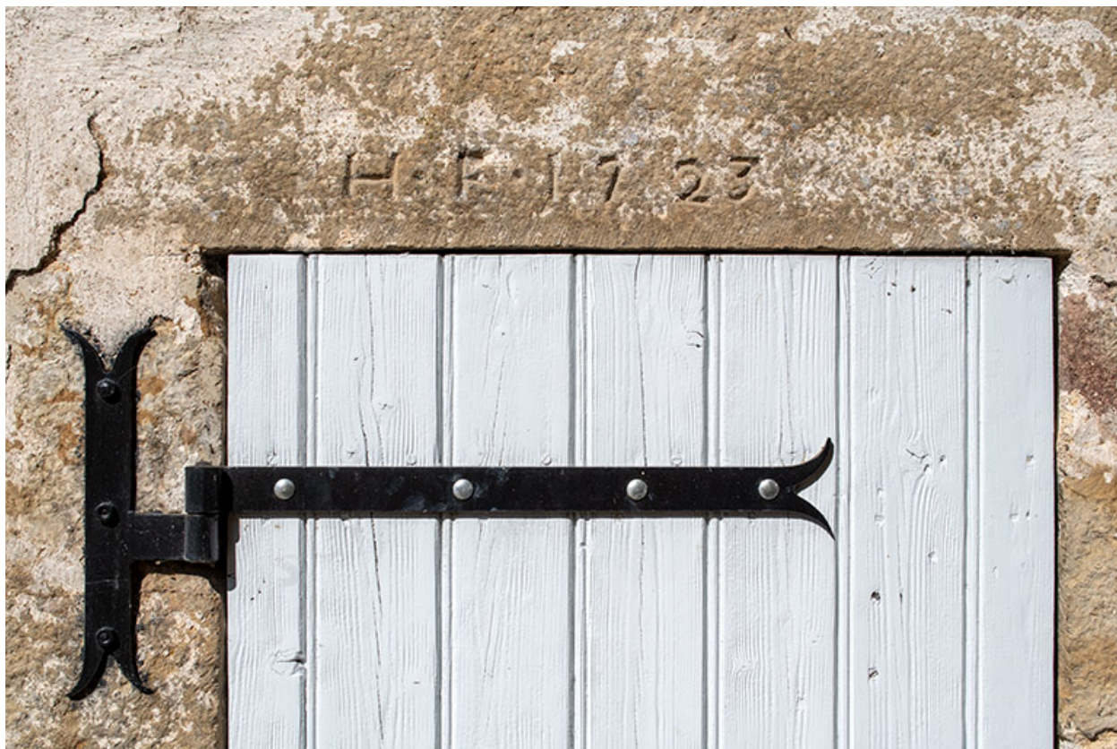
Le linteau de l'une des fenêtres du four à pain.
