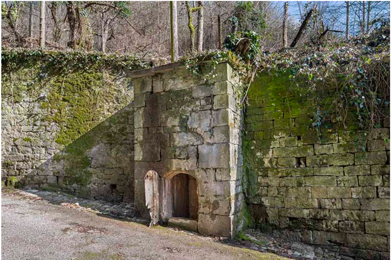
Escalier de Saint-Anatoile. Captage d'une source.
