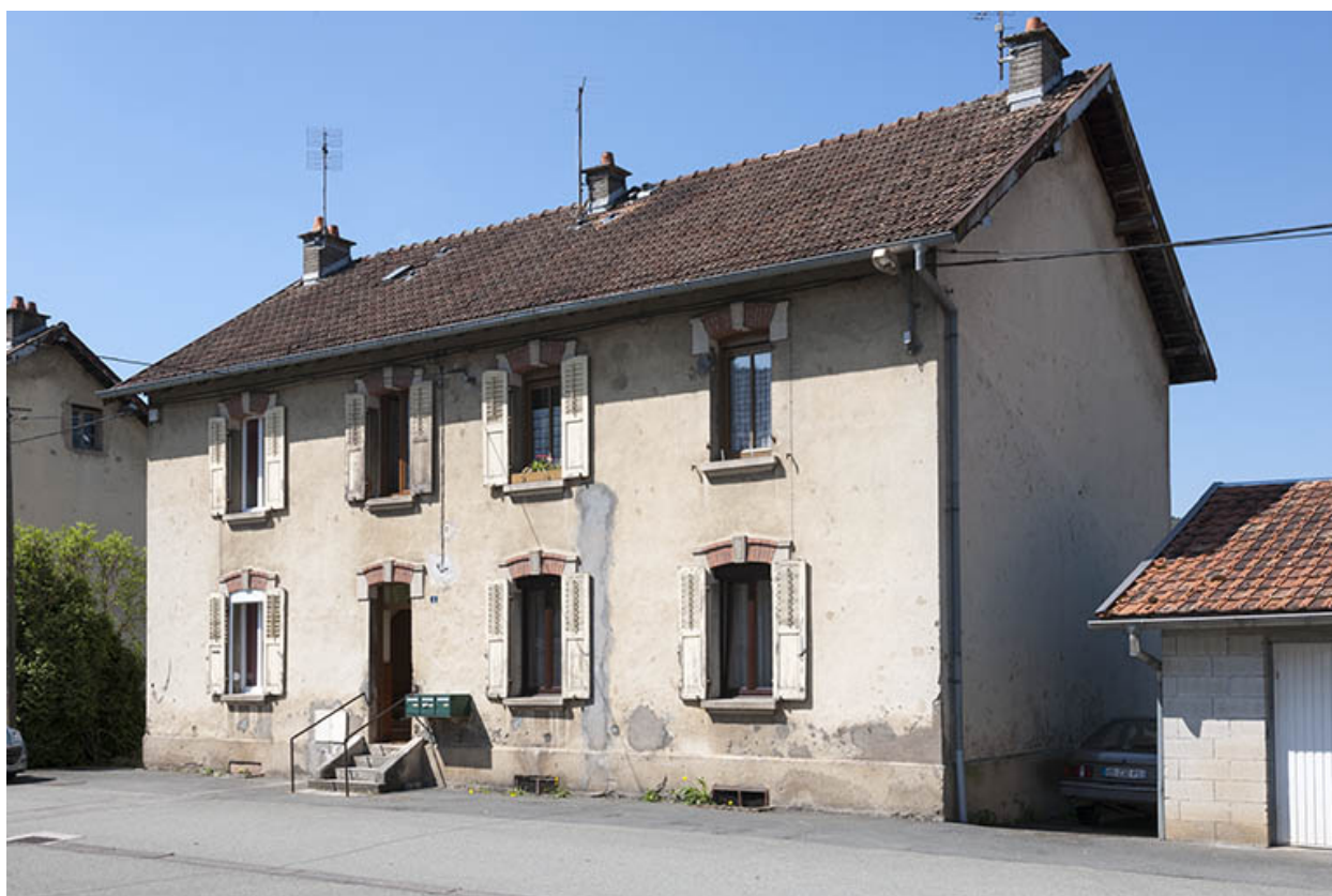
Habitation vue de trois quarts droite.
