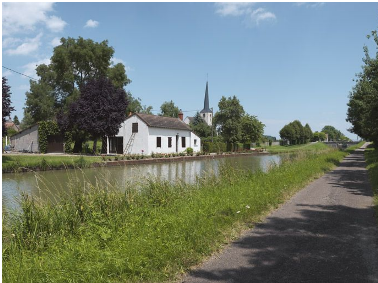
Vue de 3/4 depuis la rive gauche.
