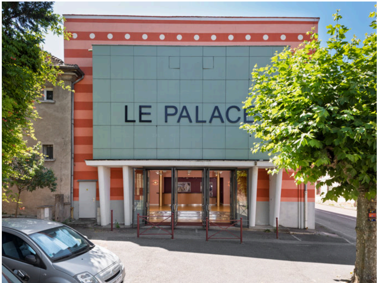
Salle de spectacle : façade antérieure.
