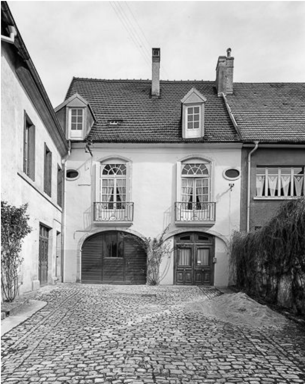
Maison (AE 105) 1 rue Pierre Vernier : vue générale.
