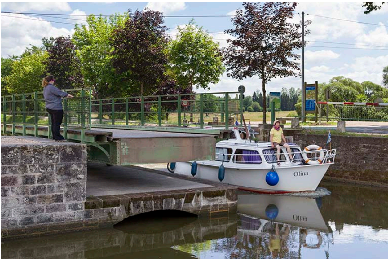
Passage d'un bateau de plaisance et maintien du tablier ouvert.
