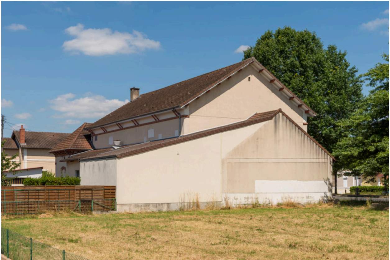
Façades postérieure et latérale droite.
