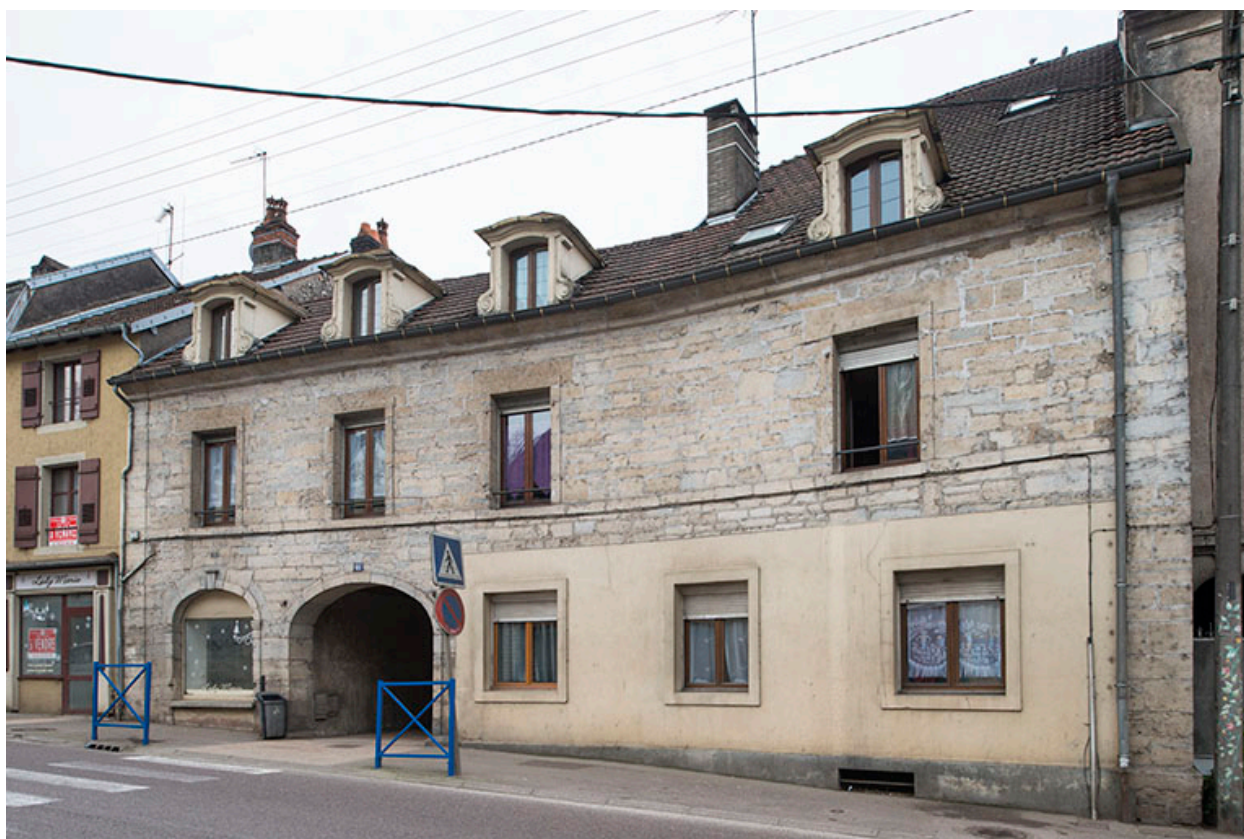
La façade principale depuis la rue.
