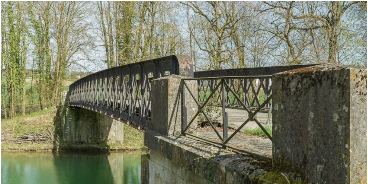
Le pont, vue d'ensemble.
