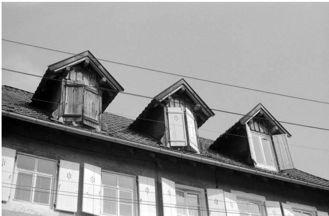
Façades antérieure : détail des lucarnes.
